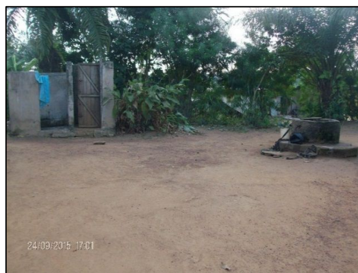
Photo n°1 et n°2 : Puits situés en aval de latrines à fosse sèche combinée à une fosse de douche
