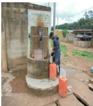
Photo n°2 : Un puits à poulie Orly 2
