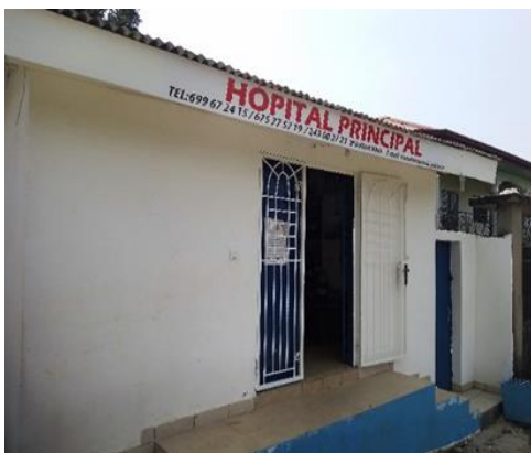
Photo n°4 : Hôpital principal de Logpom
