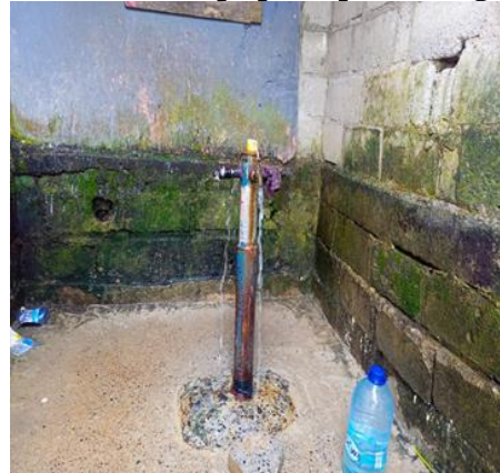
Photo n°2 : Pompe publique à Sotéga
